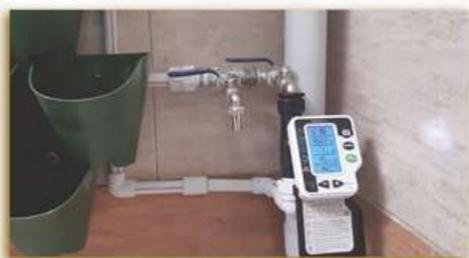
محل قرارگیری مکانیزم قطع و وصل، بسته به نیاز بهره بردار می تواند در دسترس و یا خارج از دسترس باشد. اگر دوره و زمان آبیاری توسط یک نفر نظارت می شود بهتر است در دسترس باشد.
